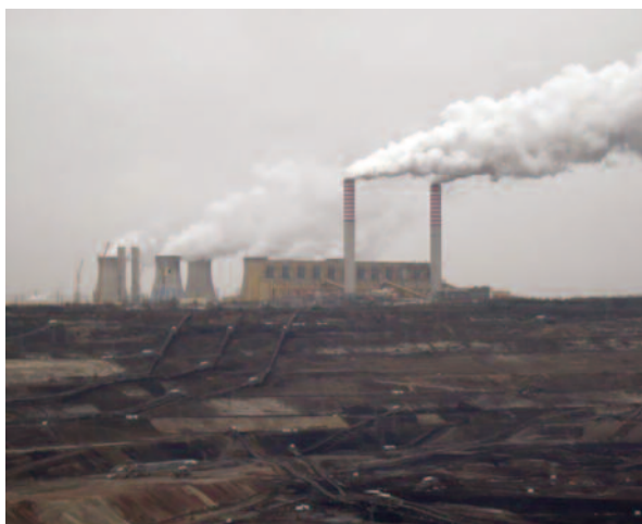
KOHLEKRAFTWERK BELCHATÓW, POLEN. © Jacek
