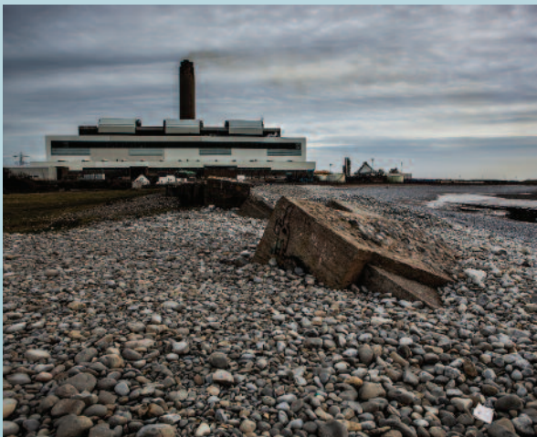
KOHLEKRAFTWERK ABERTHAW, WALES, GB. © cliff hellis
