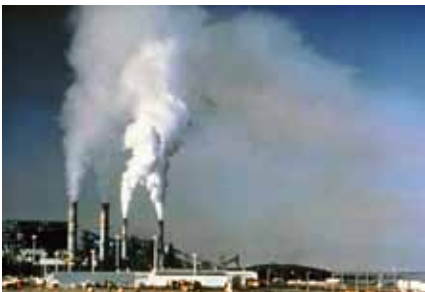
1. Utilisant des combustibles fossiles pour générer de l'électricité
